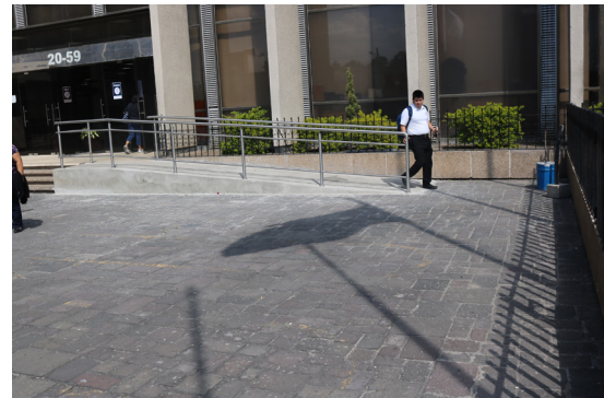
Rampa de acceso al Museo del Grabado en Acero Mariano Peraza (MUGA) ubicado en el edificio del Ministerio de Finanzas Públicas (MINFIN).
